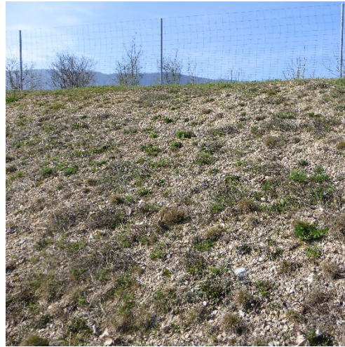
Erscheinungsbild 4: lückiger Bestand mit Feucht- und/oder Trockenstellen
